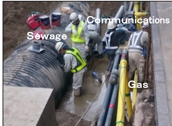
【Photo 10. Underground facilities】
