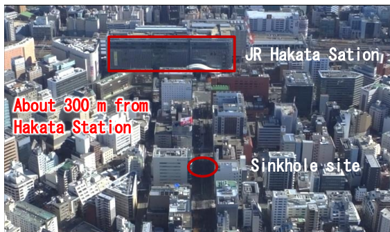
【Photo 1. Location of sinkhole】
