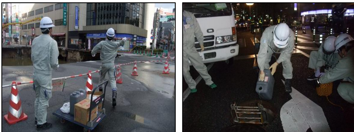
【Photo 6. Injecting disinfectants】
