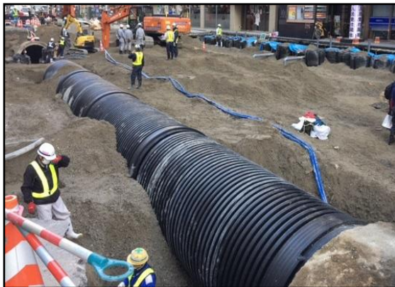
【Photo7. Status of recovery of Hie No. 1 trunk line】
